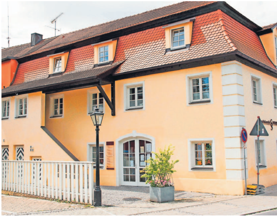
Für das Offene Haus OHA in Roth fällt eigentlich seit Januar Miete an. Obwohl die Stadt den Mietzuschuss zugesichert hat, fließt bisher nichts. Der Verein fühlt sich im Stich gelassen. Foto: Scherbel
